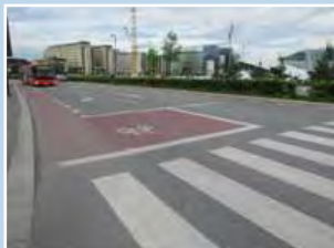
Pas rowerowy zakończony przed skrzyżowaniem służą rowerową, Oslo fot. M. E. Sokołowicz
