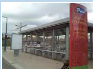
Przechowalnia dla rowerów Park+Tram, Montpellier fot. M. E. Sokołowicz
